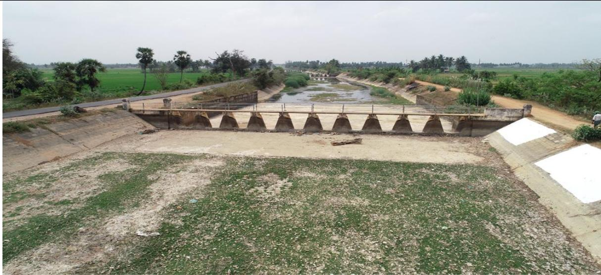
**FIGURE 4 : THANJAVUR DISTRICT – REHABILITATION DROP NO.1 @ LS.62.705 KM OF G.A.CANAL CHELLAMPATTI VILLAGE UNDER STATE FUND (ERM PACKAGE NO.8)**
