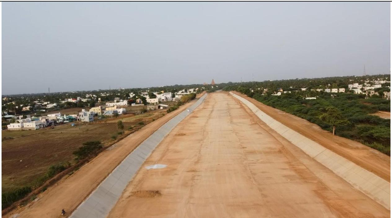
**FIGURE 3 : AFTER CONSTRUCTION THANJAVUR DISTRICT – REHABILITATION BEFORE BED LINING @ LS 38.500 KM OF G.A. CANAL PACKAGE-3**
