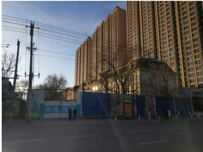
图 6-6 银通铂翠园网点及居民楼现状
