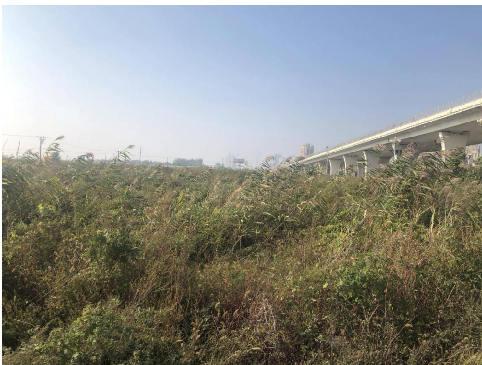
图 3-34 盘锦辽东湾城际公交综合服务中心现状
