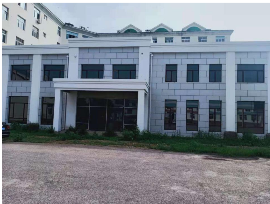
图 3-22 葫芦岛调度中心设备及系统安装地点
