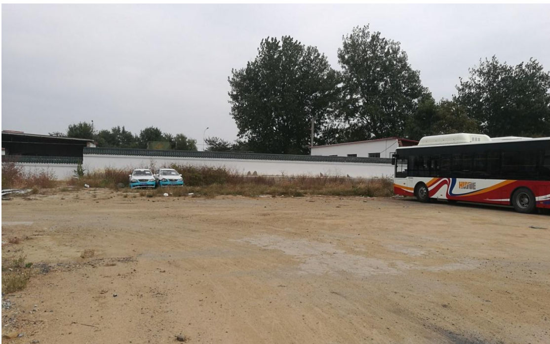
图 5-20 葫芦岛公交公司 1 号充电站
