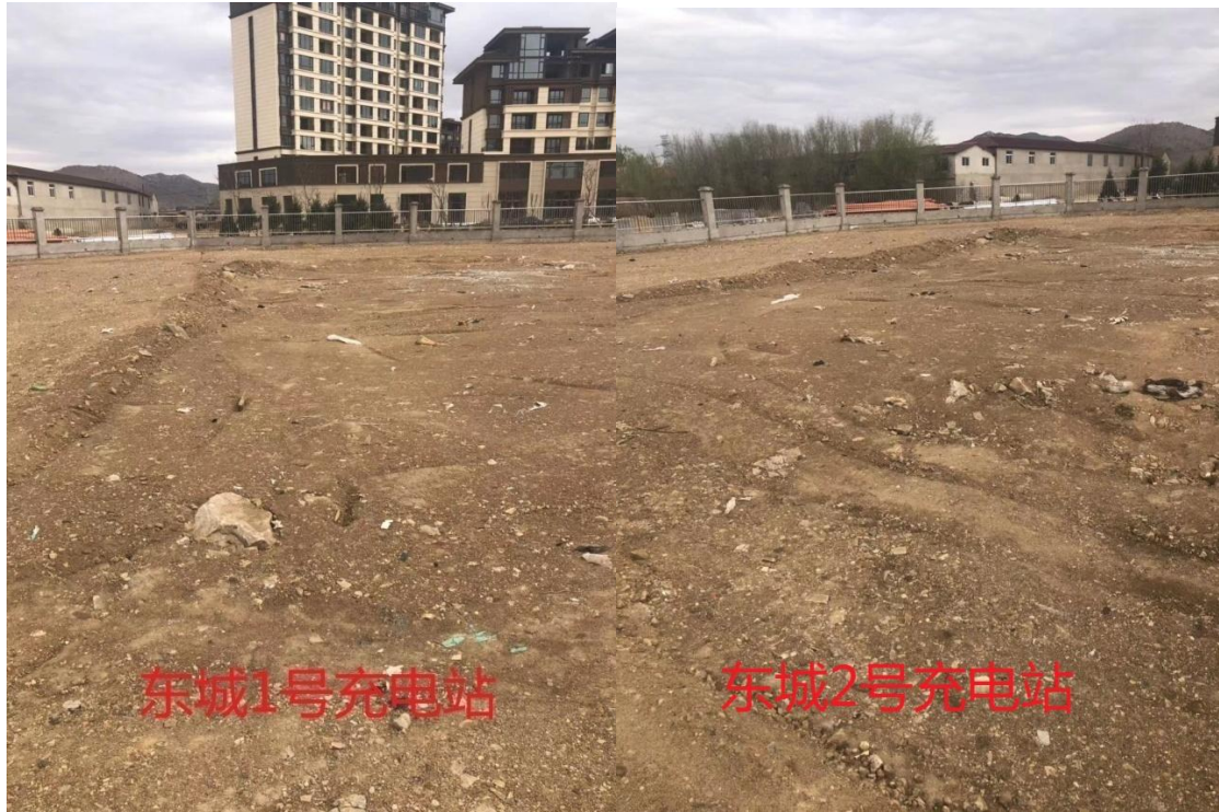
图 5-18 葫芦岛东城 1 号充电站图 5-19 葫芦岛东城 2 号充电站
