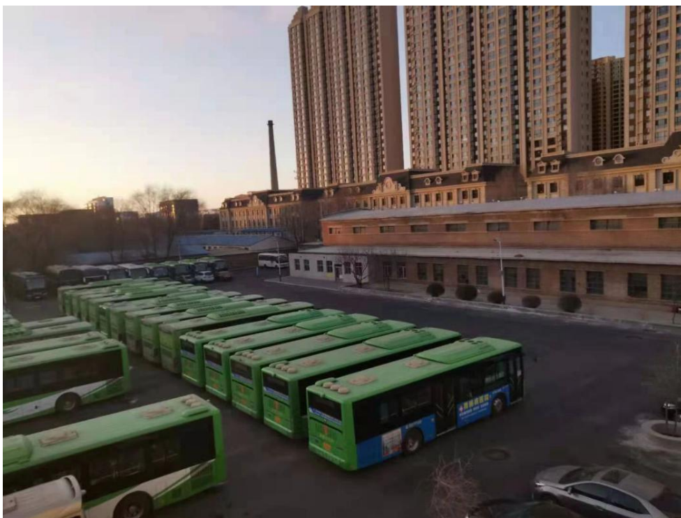
图 3-32 阜新拟建新能源车维保场现有场地
