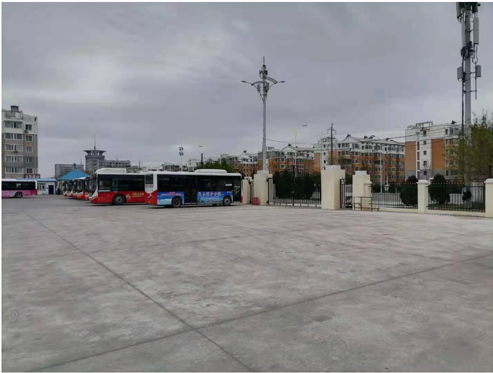
图 5-16 阜新高铁站停车场
