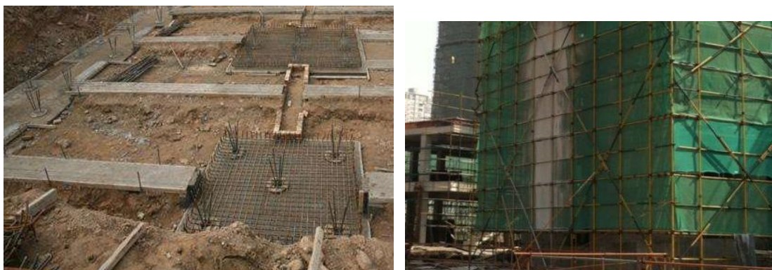
图 3-29 地基基础施工
