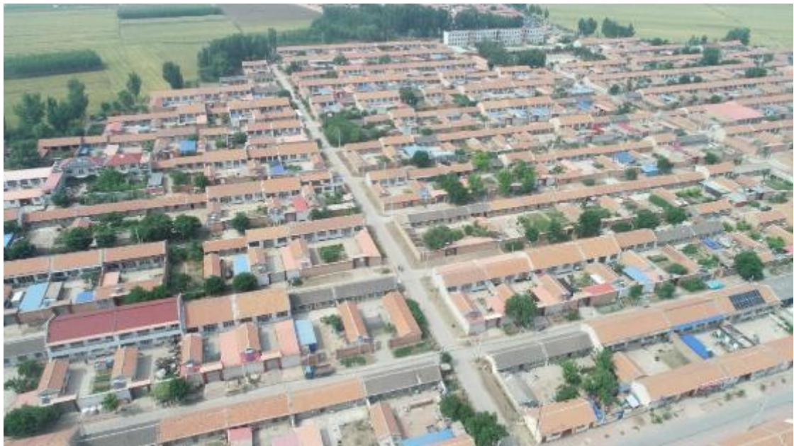
图4.2-1 宝坻区农村住房航拍照片
