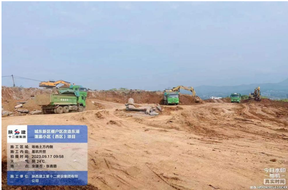
图 5-4 安置小区（一期）开工与建设现状（2023年9月）
