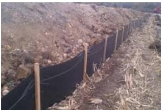
*Рисунок 6 – Иловое ограждение вокруг отвалов грунта для предотвращения эрозии почвы и чрезмерного осадения с ливневыми стоками.*
