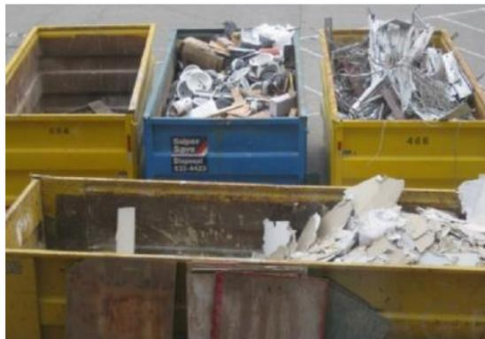
*Рисунок 5 – Строительные отходы будут сортироваться и временно собираться на стройплощадке для последующей надлежащей утилизации/переработки за пределами стройплощадки.*
