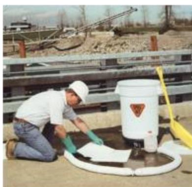
*Рисунок 7 - На строительной площадке всегда будут находиться комплекты для предотвращения и очистки разливов топлива/химических веществ в чрезвычайных ситуациях.*
