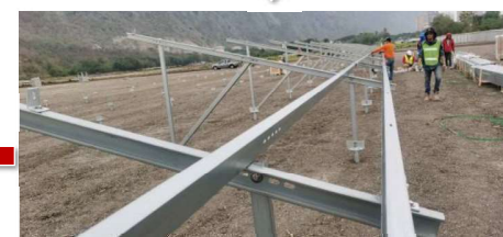
ติดตั้งโครงสร้างรองรับแผงเซลล์แสงอาทิตย์
