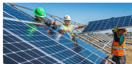
ติดตั้งแผงเซลล์แสงอาทิตย์
