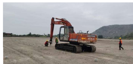
วางแผนการเจาะเสาเข็ม
