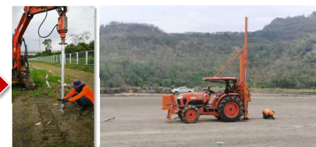
เจาะเสาเข็มด้วยหัวเจาะเฉพาะ
