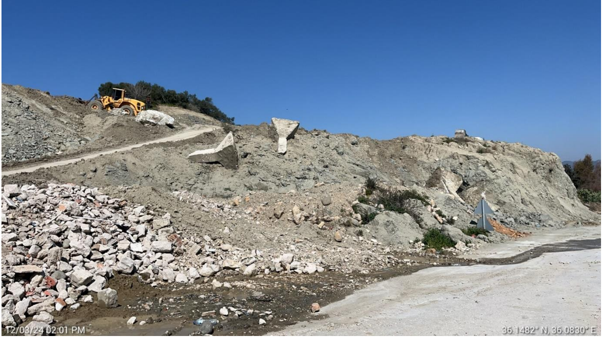
Şekil 28. Heyelan Islah Çalışmaları
