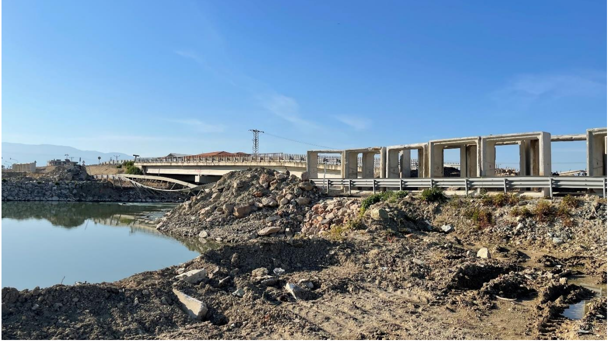
Şekil 15. Demirköprü İnşaat Alanı
